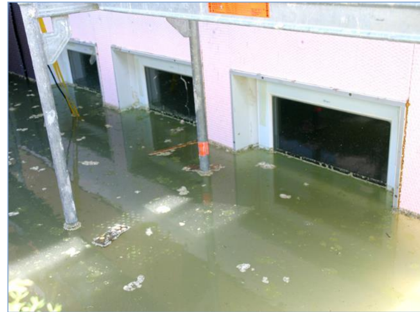
Verankertes, abgedichtetes Fenster, Bild: Broschüre Wenzler Bausysteme
