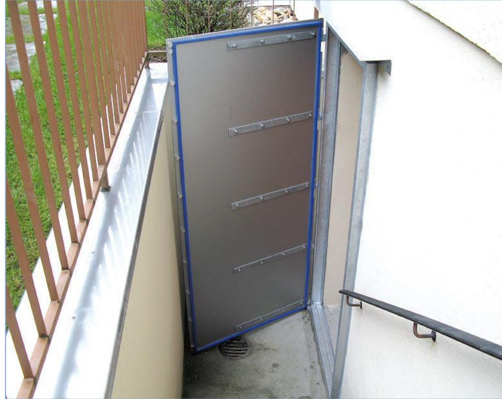
Druckwasserdichte Tür als Vorsatzblatt, Bild: Fa. WHS
