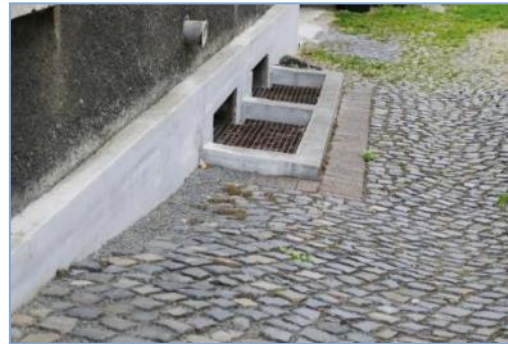
Aufkantung Lichtschacht, Bild: SE Schwerte
