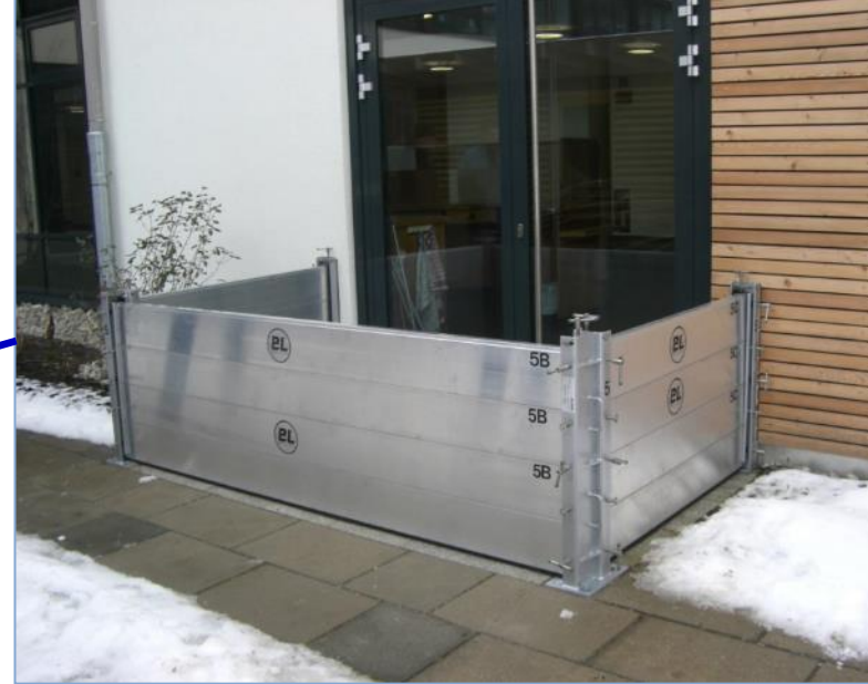
Errichtung mobiles Dammbalkenwehr
