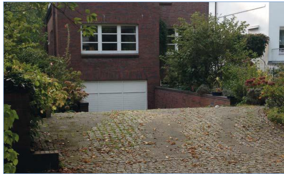
Schutz durch Überhöhung als Schwelle, Bild: Broschüre StEB Köln AöR
