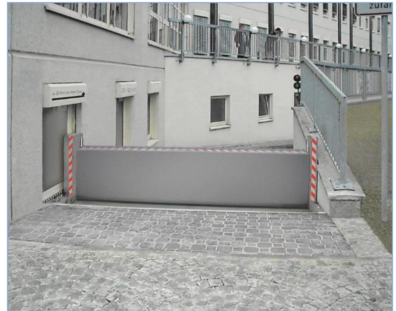
Klappschott geöffnet und geschlossen, Bild Fa. Anhamm
