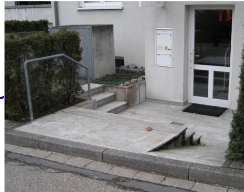
Errichtung einer dauerhaften Schwelle
