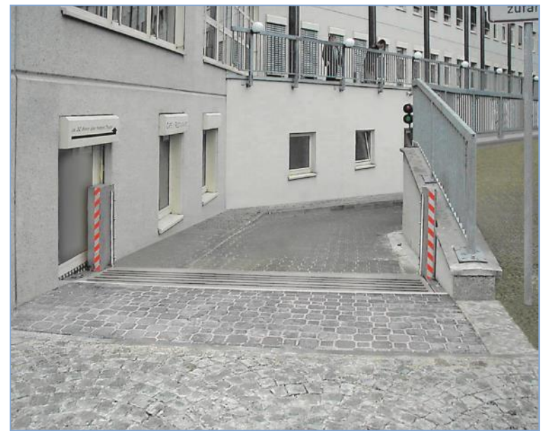
Klappschott geöffnet und geschlossen, Bild Fa. Anhamm
