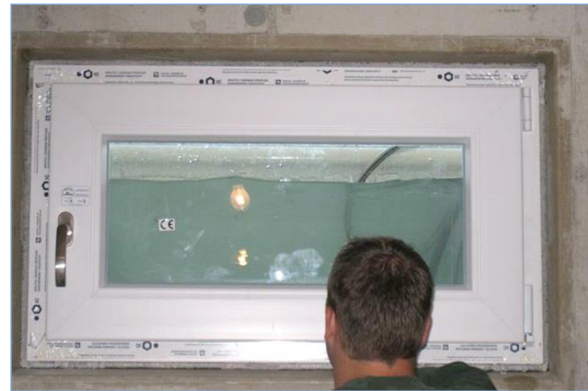
Verankertes, abgedichtetes Fenster, Bild: Broschüre Wenzler Bausysteme
